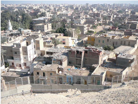
Fig.8 迫る住宅地との間に築かれたフェンス
