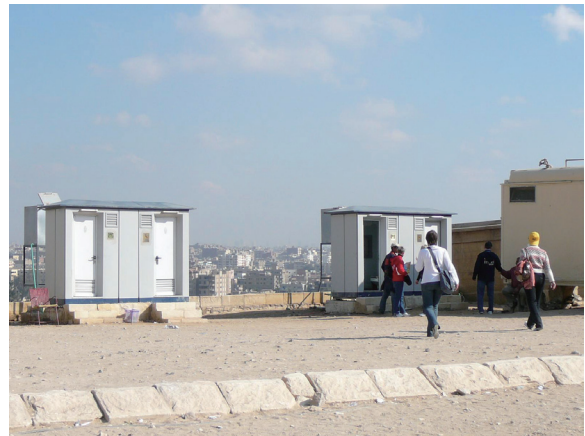
Fig.5 整備の必要なトイレ
